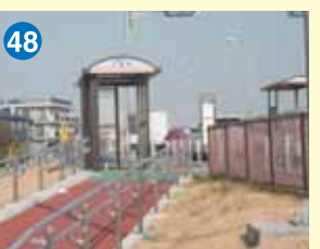
48 江戸川病院前のスロープ・北篠崎バス停の整備
