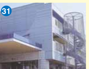
31 障がい者支援ハウスの建設
