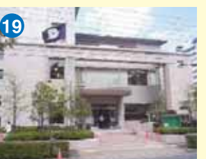
19 西葛西図書館の新設
