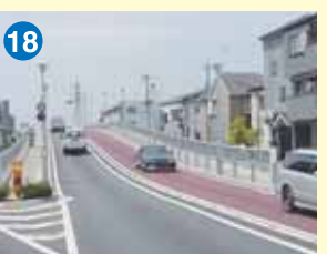
18 三角橋の建設、新川整備促進
