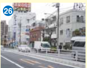
26 葛西橋通りに中央分離帯を設置
