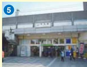
5 平井駅北口地下駐輪場の建設・駅前広場の整備促進
